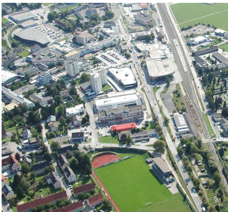
Zentrum Süd / Ansicht von Westen, 2011
