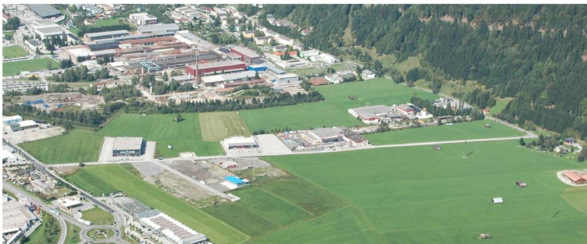
Ansicht von Osten, 2011
