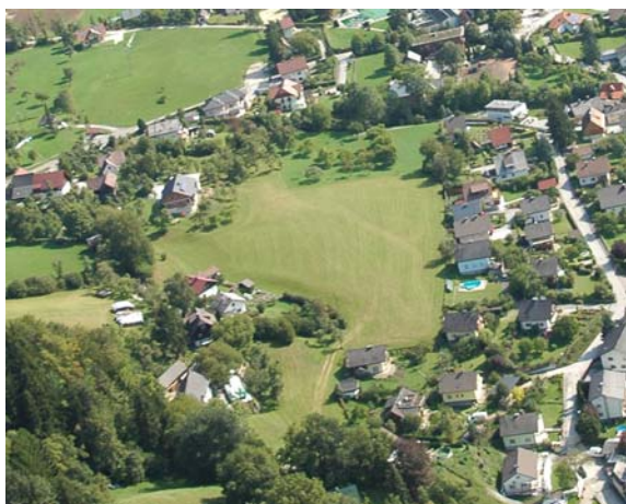
Gst. 1143/2 + Umfeld / Ansicht von Westen
