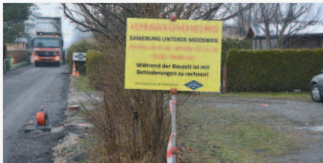
Noch rechtzeitig vor Winterbeginn konnte die Generalsanierung des Unteren Moosweg abgeschlossen werden.
